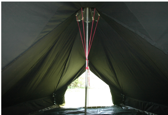
Zelt Mittelstütze mit richtig montierter Abdeckhaube
